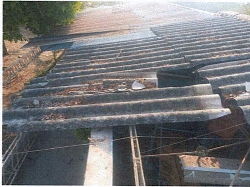
**Foto 1:** Desmante del techo deteriorado en los Salones
