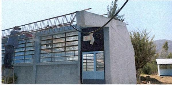
**Foto 1:** Limpieza a la estructura del techo
