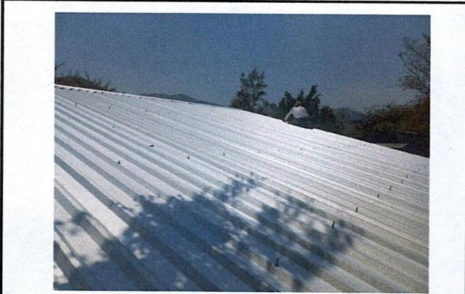
Foto 3: Colocación de Pernos para asegurar el techo
