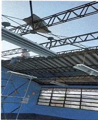
**Foto 3:** Aulas despejándose del techo deteriorado
