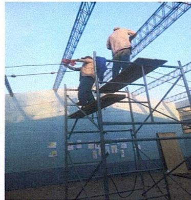
**Foto 2:** Limpieza de óxido de estructura del techo
