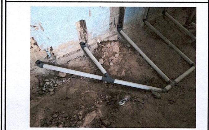
**Foto 3:** Cambio de Tubería de drenaje e Hidráulica
