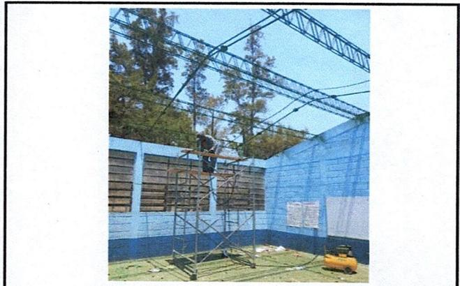
Foto 2: Asegurando estructura para colocación de láminas
